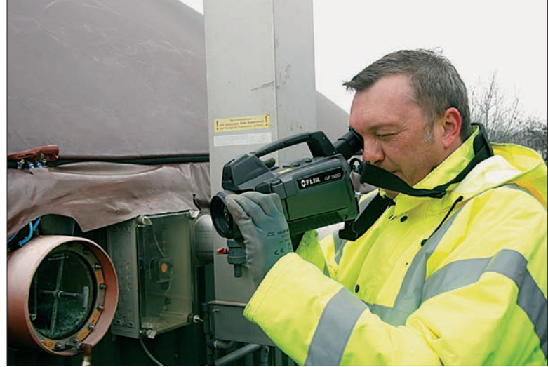
Stephan Neitzel prüft mit der Kamera typische Stellen der Biogasanlagen, bei denen Gas entweichen kann.
